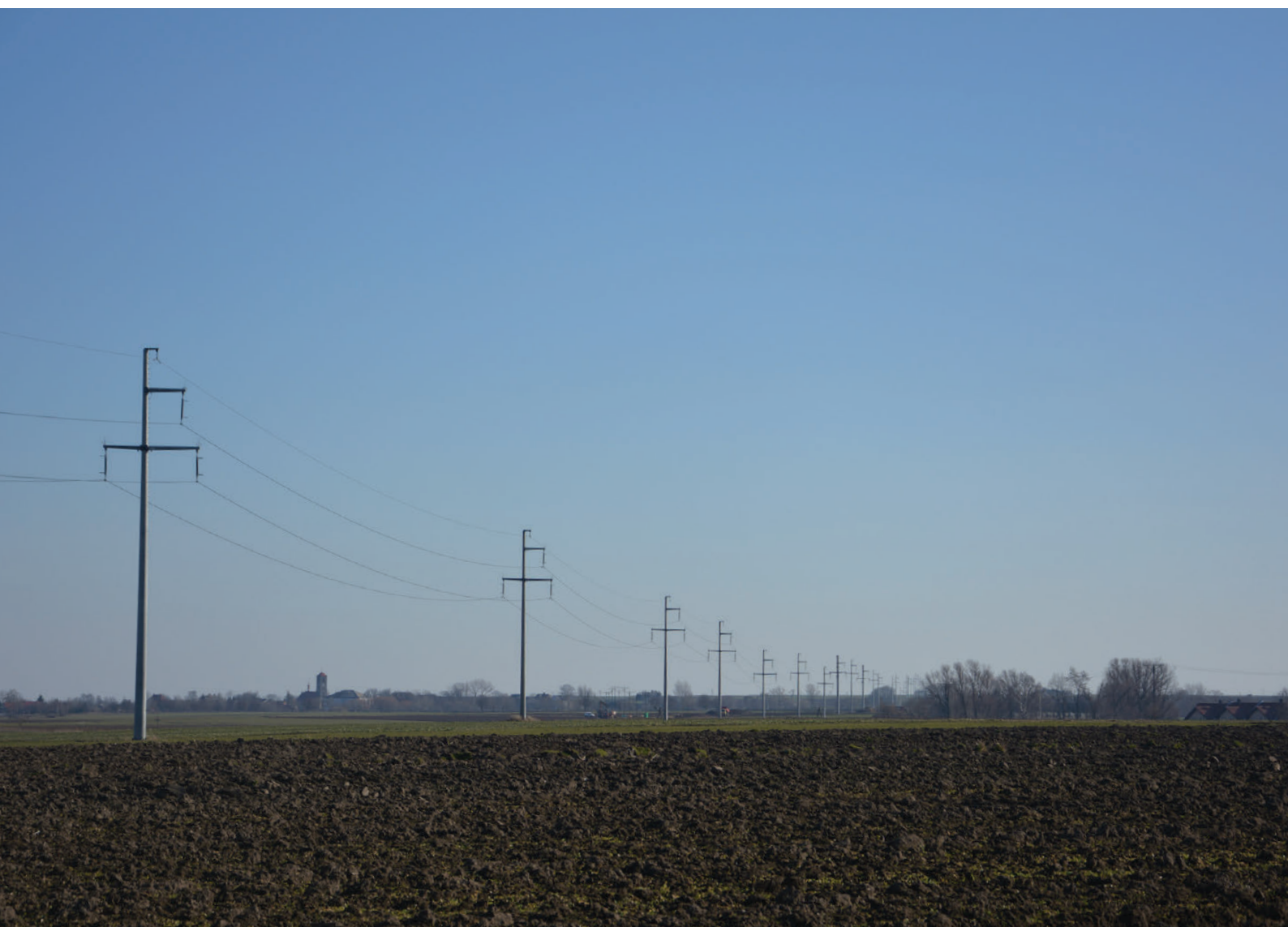
Linia 110 kV po wymianie słupów na żerdzie strunobetonowe
