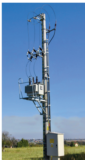
SŁUPOWE STACJE TRANSFORMATOROWE
